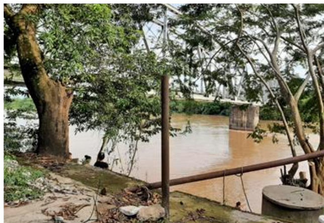
Figura 4.2 Localización vista general de la estación puente Sogamoso (2406702)
